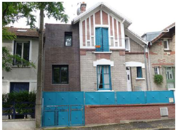
Extension à Arcueil (94), par David Serero. Les proportions et le matériau choisis s'intègrent plutôt bien à l'ensemble malgré un léger « flottement » des fenêtres contemporaines (la couleur des menuiseries et ferronneries mettent en revanche peu en valeur l'ensemble).
