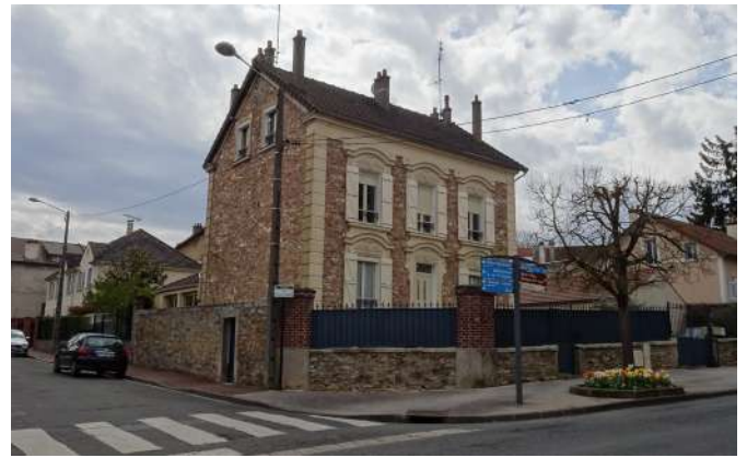
Exemple de maison bourgeoise avec façade principale en retrait de la rue. Les murs sont en pierre meulière et les encadrements*, corniches*, bandeaux* et chaînages d'angle* sont en pierre calcaire.
