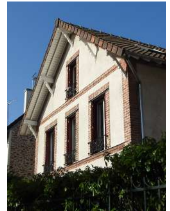
Exemple de débord* de toit simple en bois. C'est un modèle classique dans le paysage domontois.
