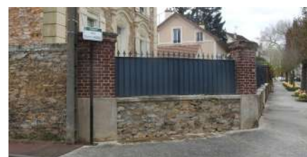
Mur-bahut* en meulière à rocaillage et grilles en fer forgé avec pare-vues*. Le mur bahut est agrémenté de potelets en briques et béton.
