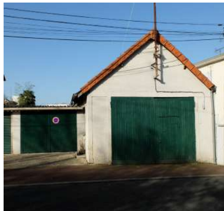
Garage ancien de facture simple avec porte en bois qui s'intègre bien avec l'environnement proche.
