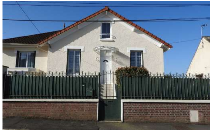
Exemple de maison datant du début XX e . En retrait de la rue, elle est séparée par un mur de clôture et un portail de facture simple.
