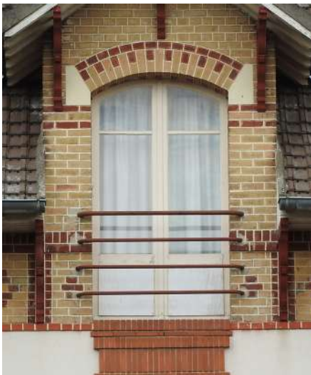
Menuiseries cintrées d'origine conservées.
