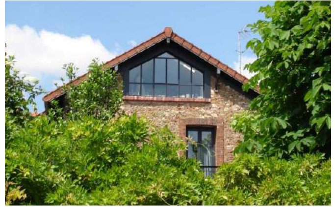
Bel exemple de baie et de menuiserie contemporaines intégrées sur le mur pignon d'une maison en meulière traditionnelle. Source photo CAUE 77 extraite du document « L'éclairage des combles » STAP/DRAC 77
