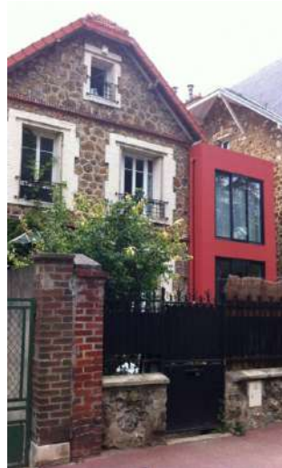
Extension à Saint-Cloud (78) par Calixte Clément architecte. Les proportions sont adaptées, la couleur un peu vive.
