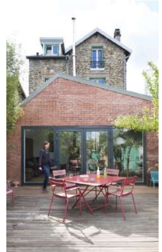
Extension à Vanves (92) par Agnès et Agnès architecture, le matériau et les dimensions permettent son intégration.
