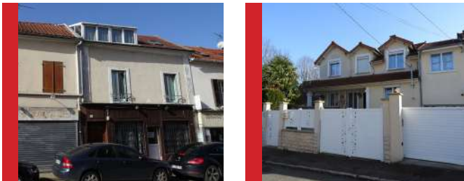
Les lucarnes créées doivent prendre en compte la composition de la façade et le style de l'édifice pour ne pas former une excroissance sur le bâtiment. Ci-dessus à gauche, la lucarne ne respecte ni les proportions du bâti, ni la pente du toit. A droite, les lucarnes de diverses largeurs et pans de toiture déséquilibrent la façade.
