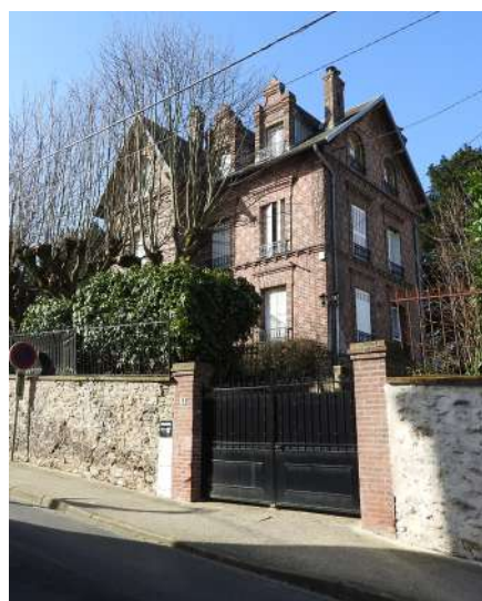
Haut mur en pierre meulière surmonté de grilles en fer forgé.
