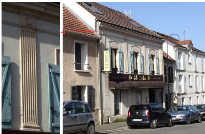
Maisons rue Pasteur et détail de pilastre
