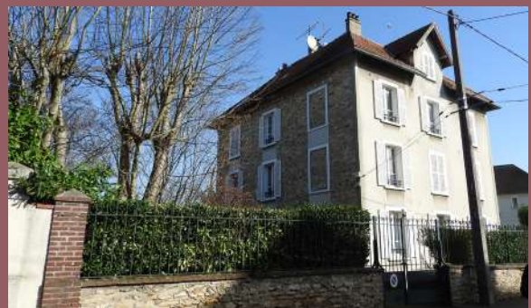
À gauche meulière recouverte de ciment et à droite enduit au ciment masquant la pierre.
