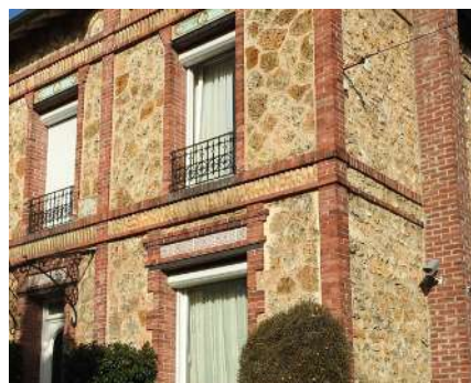
D'une façade à l'autre le traitement de la meulière peut être différent. Encadrements, chaîne d'angle, bandeaux et corniche en briques
