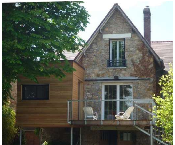
Extension à Vaires-sur-Marne (77) par Cabanes et Chazottes Architectes. Le bois dans ses tons naturels se marie bien avec la pierre meulière. Les proportions sont adaptées au bâti existant.
