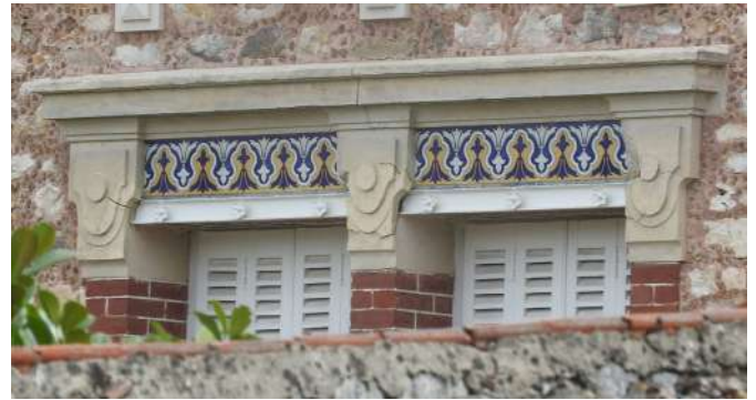
Les frises aux motifs floraux ornent généralement le dessus des fenêtres et permettent dans certains cas de masquer le linteau*. Ici linteau* métallique et frise se juxtaposent.
