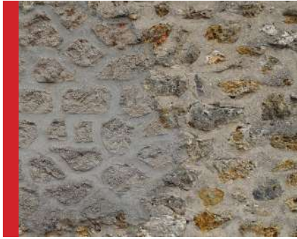
Mise en œuvre de joints en ciment gris recouvrant partiellement les meillons*.
