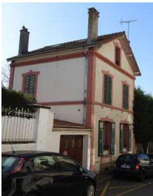
Maison alignée avec la rue
