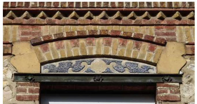
Linteau métallique surmonté d'un décor en ciment prompt
