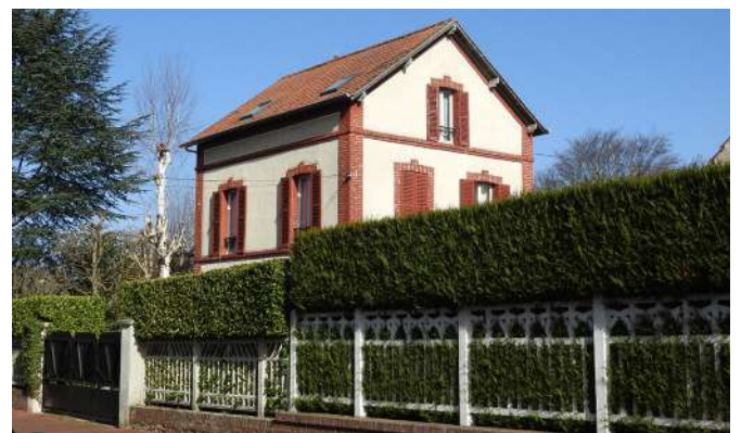
Maison en retrait avec mur-bahut* en brique surmonté d'une clôture en ciment moulé. La façade est décorée avec des briques.
