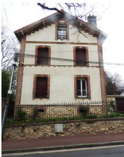
Mur-bahut* traité de la même manière que le soubassement de la maison.
