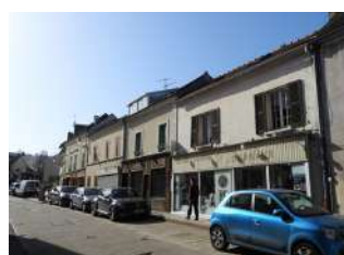
Maisons alignées avec la rue avec commerces en rez-de-chaussée.
