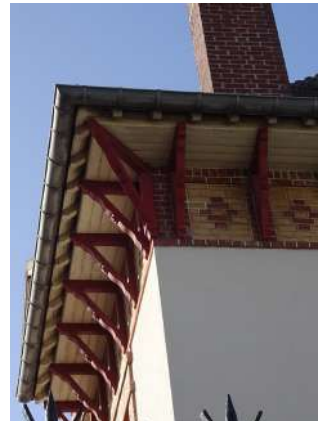
Exemple de débord* de toit ouvragé sur demeure bourgeoise avec aisseliers* en bois s'appuyant sur un bandeau* large en briques venant couronner l'édifice.
