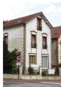
Façade enduite à la chaux avec badigeon en couche de finition.
