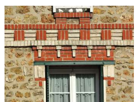
Assemblage de pierres meulières et briques rouges et jaunes.
