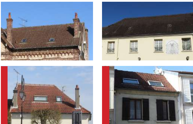
Les châssis de toit créés doivent prendre en compte la composition de la façade et le style de l'édifice pour ne pas former une verrue sur le bâtiment. Ci-dessus en haut, ils s'intègrent discrètement au toit. En dessous, ils sont en saillie par rapport au plan du toit et sont trop larges.
