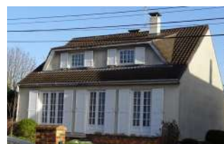
Exemple de couverture en tuiles mécaniques en béton. À droite adapté à la typologie à gauche toit à l'origine en tuiles mécaniques.
