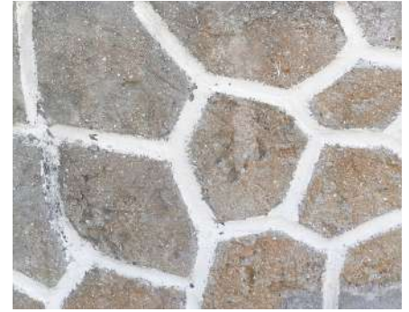
Exemple d'imitation de meulière avec joints blancs possible sur les murs de clôture ou en soubassement* mais à éviter en façade car trop contrasté..
