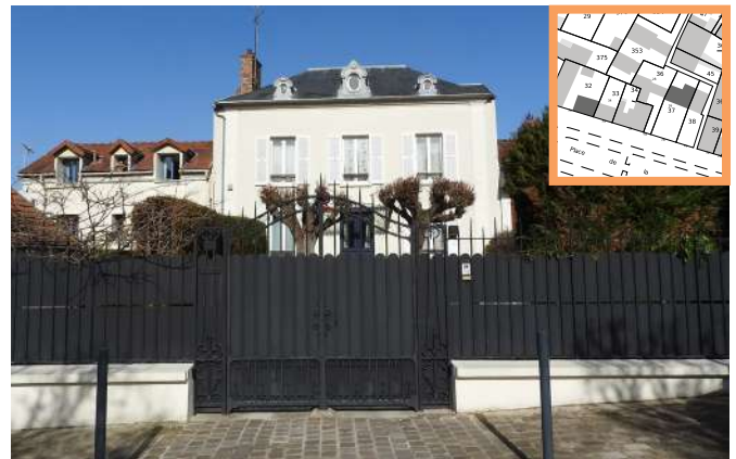
Demeure qui s'implante en fond de parcelle avec une cour arborée en partie avant. Donnant sur la place de la République, elle est séparée de la rue par un mur-bahut* surmonté d'une grille.
