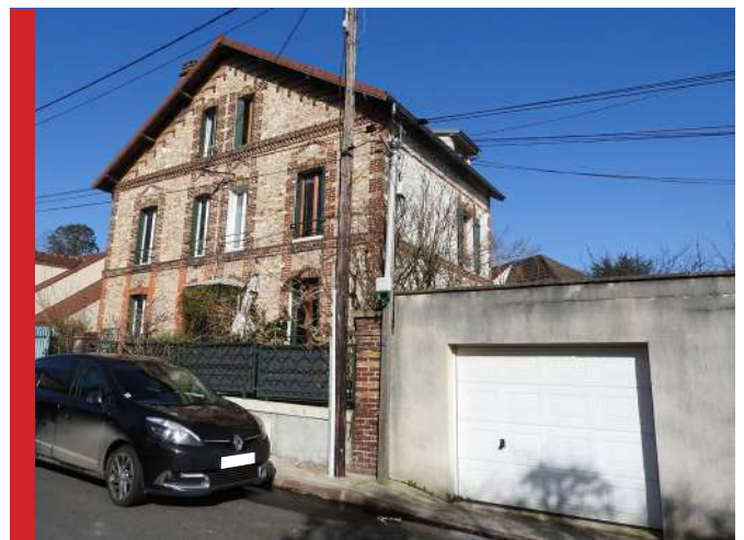
Exemple d'un garage basique en béton non enduit et porte en PVC qui dénature fortement l'environnement proche et lointain.
