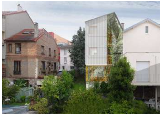
La même construction vue depuis les jardins. Le toit est à deux pans pour rester en cohérence avec les deux maisons voisines.
